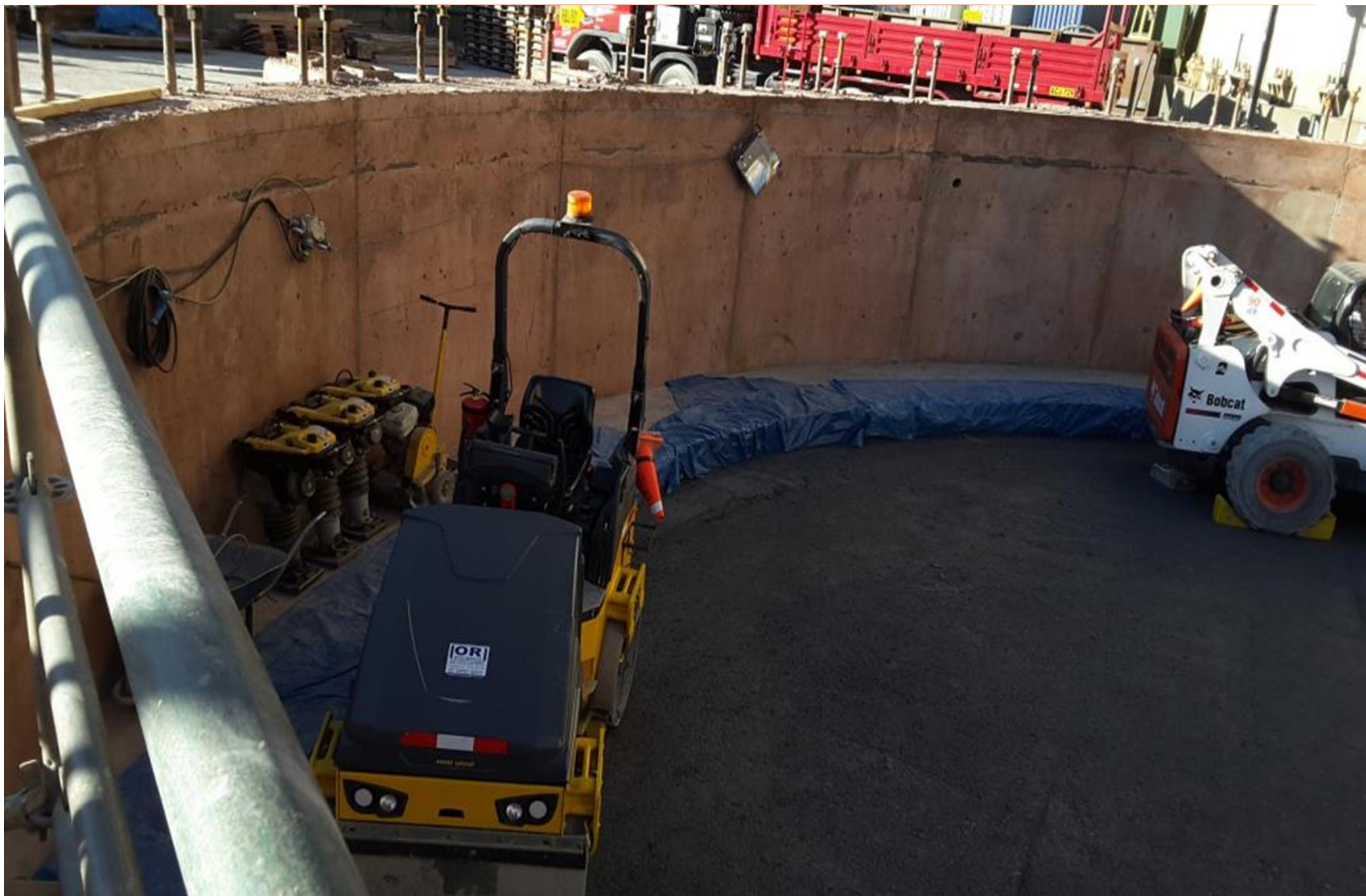
Relleno y compactación del cemento interno del tanque
