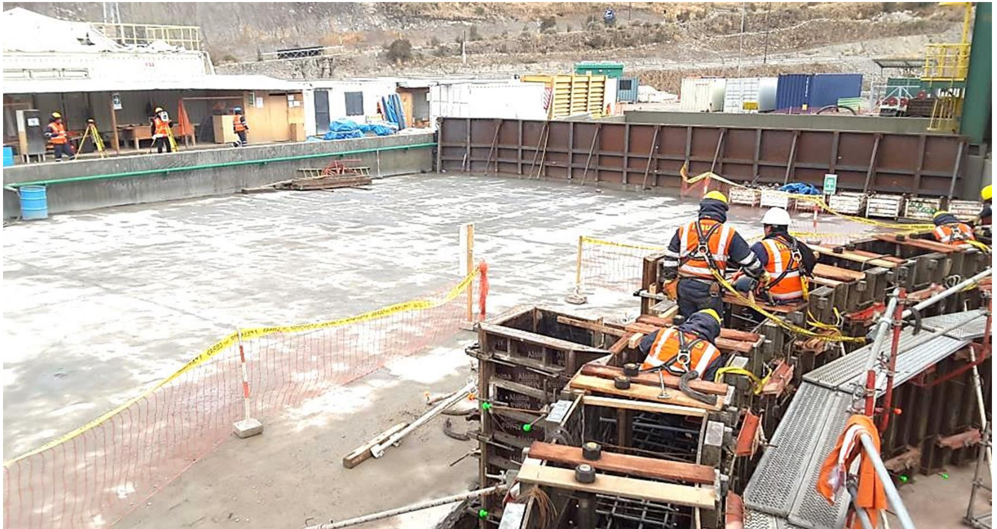
Montaje de pernos para tanque
