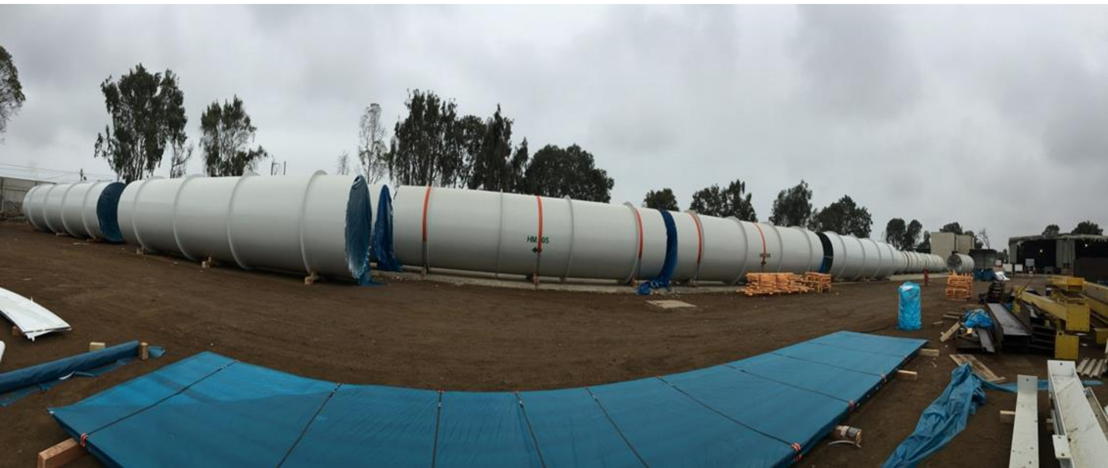
Embalaje de tuberías en acabado
