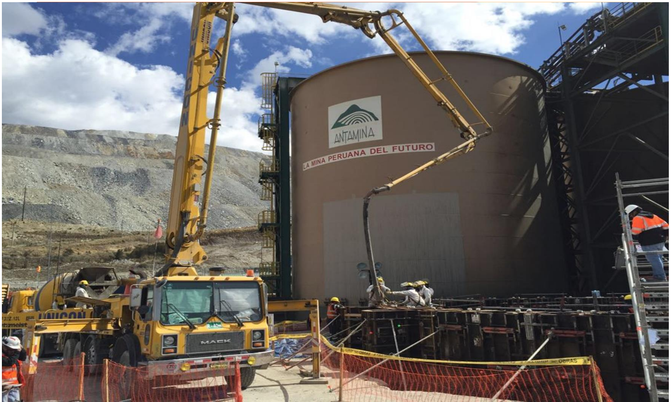
Vaciado de concreto en anillo de tanque
